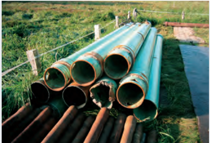
▷ Abb. 6 Ausgebauete Rohre DN 250, Stahl beschichtet
