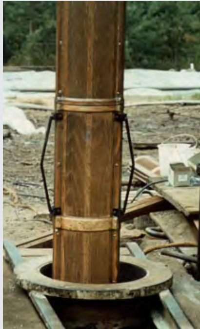
Abb. 3 Filter mit Führungsbügeln zur Zentrierung des Brunnenausbaus
