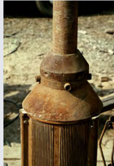
Abb. 5 Schüttkonus für den Schüttvorgang der äußeren Kiesschüttung (verlorener Brunnenausbau)
