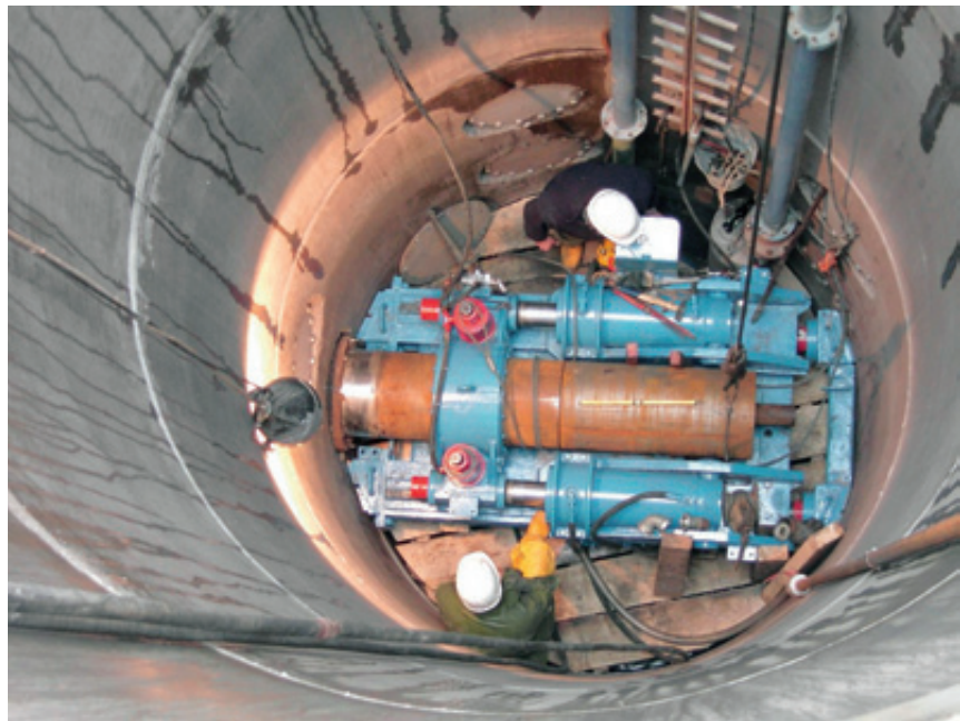
Abb. 5 Blick auf das Horizontalbohrgerät beim Vortrieb
