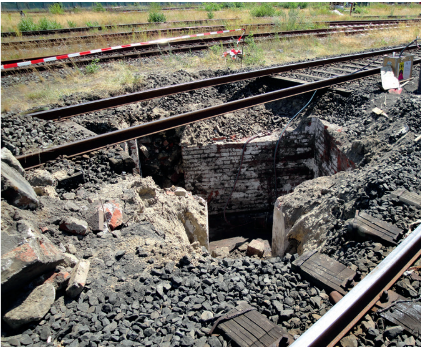
Abb.: NORD Bohr und Brunnenbau GmbH
