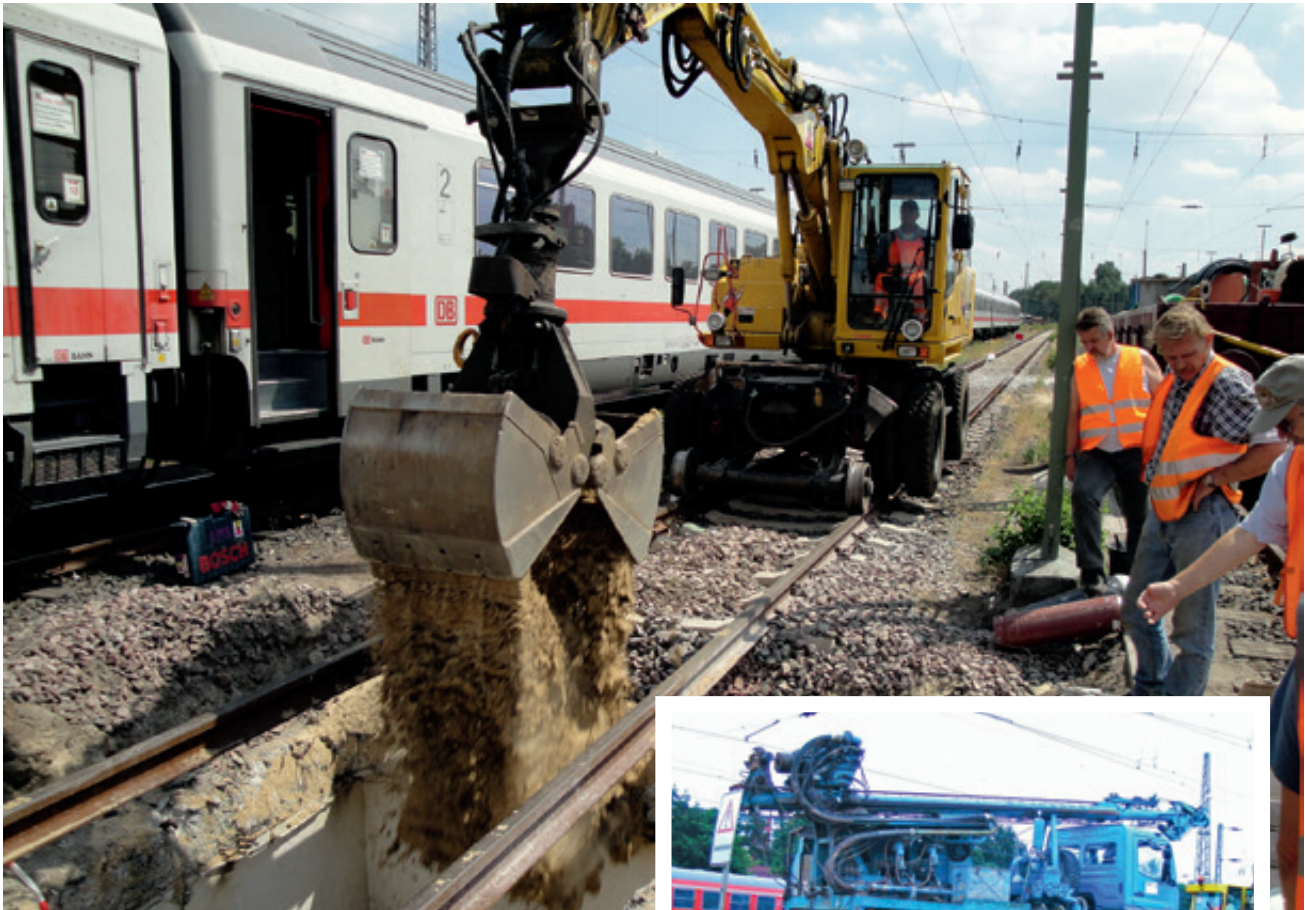
▲ Abb. 3 – Rückbau der Brunnen im laufenden Bahnbetrieb. Um Gefährdungen der Arbeiter zu vermeiden, wurde die Baumaßnahme permanent durch qualifiziertes Sicherheitspersonal begleitet.
