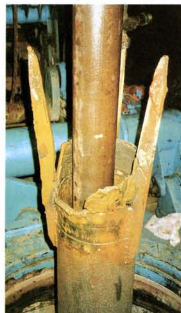
Bild 3: Ausbau der alten Filter und Vollrohre. Blick auf die Führungseisen
