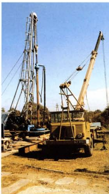
Bild 2: Baustelleneinrichtung mit Bohrgerät L3 im Betrieb
