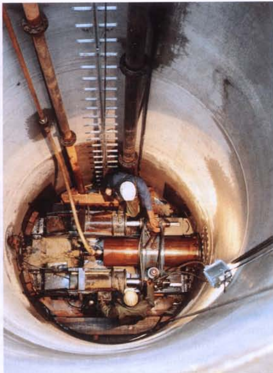
Vortriebseinrichtung im Brunnenschacht
