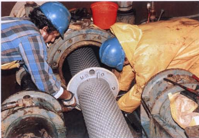
Einbau von Schlitzbrückenfiltern aus Edelstahl
