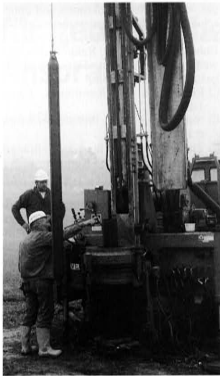
4 Freifallgewicht 250 kg, für Rammkernbohrung
